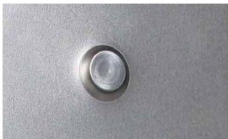
РЕЗУЛЬТАТ УСТАНОВКИ САМОПРОНИКАЮЩЕЙ ЗАКЛЕПКИ
