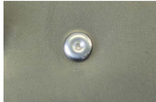
РЕЗУЛЬТАТ УСТАНОВКИ ЗАКЛЕПКИ ТЕКУЩЕЙ ФОРМЫ FLOW-FORM
